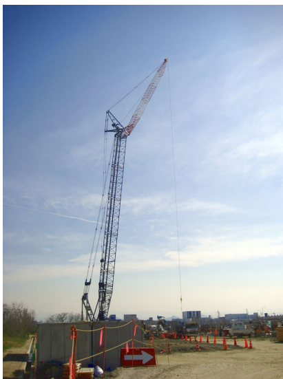
○タワークレーン
